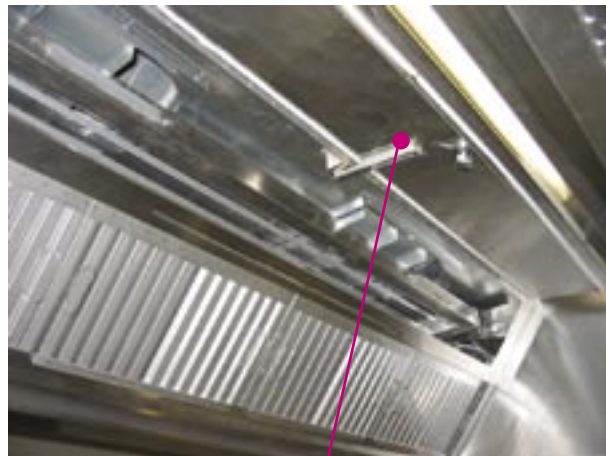
LOQUET DE BLOCAGE DE LA TRAPPE
