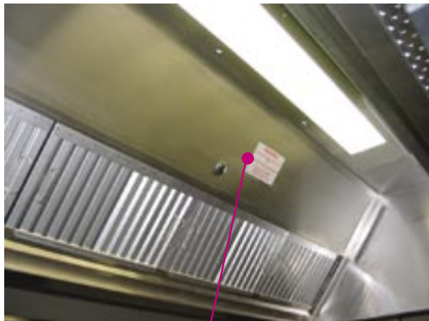
TRAPPE DE VISITE
