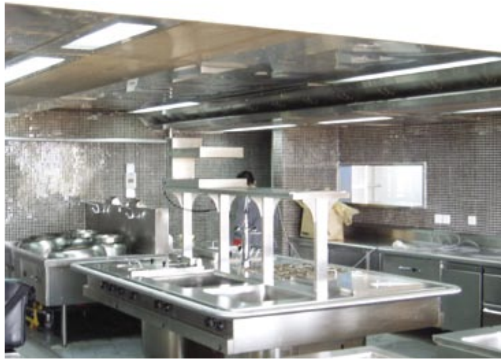
Plafond à lavage automatique, Puzhou, Chine
